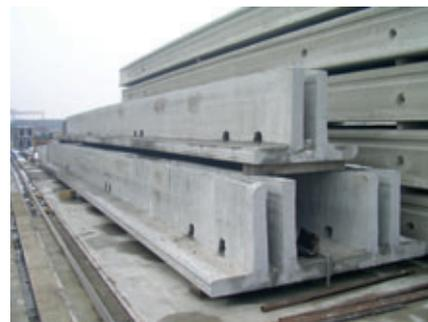
Andalo, Itália – Montagem de vigas mestras TT para uma cobertura de túnel de proteção contra queda de pedras.
