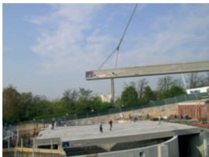
Milão, Itália – Montagem de uma laje de laje alveolar protendida de 24 metros de comprimento.
