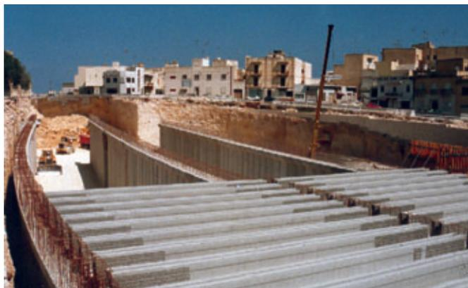
Valletta, Malta, construção de vigas mestras TT com uma altura de 800 mm para a cobertura de um túnel rodoviário.
